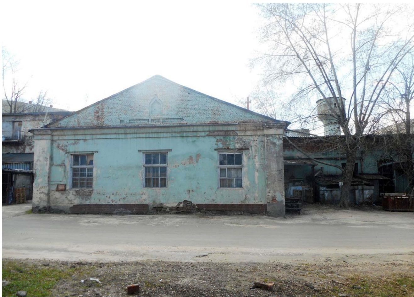
Восточный фасад одноэтажных южного и восточного крыла. 20.04.2018.
