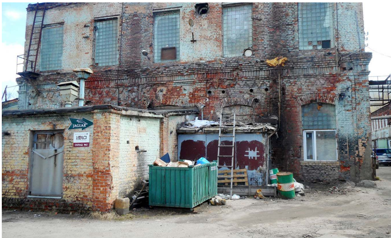
Северный фасад восточного одноэтажного крыла постройки 1885 года. 20.04.2018.
