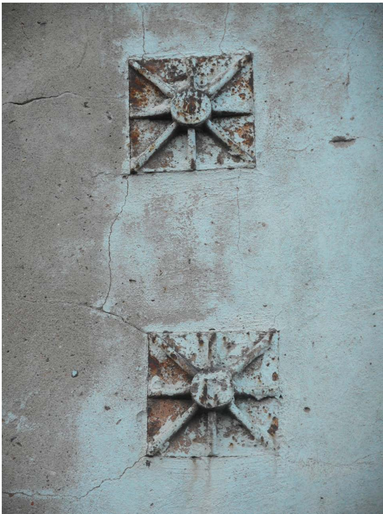
Связи на восточном фасаде западного крыла. 13.04.2018.
