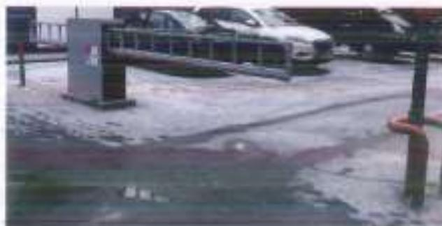
Электромеханический антиандальный откатной, с шириной перекрываемого проезда до 5 м. Конструкция шлагбаума состоит из металлической стрелы, которая выполнена из оцинкованного профиля 71 x 60 x 3,5 мм, металлического корпуса с приводом и блоком управления и стойки стреловодителя. Высота и ширина металкорпуса 136x44,5 см, длина стрелы 5 м.
