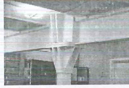
Новая броуильня (полуподвал). 1891 год. Своды Мойки, железные колонны и балки. Фото 2019 г.
