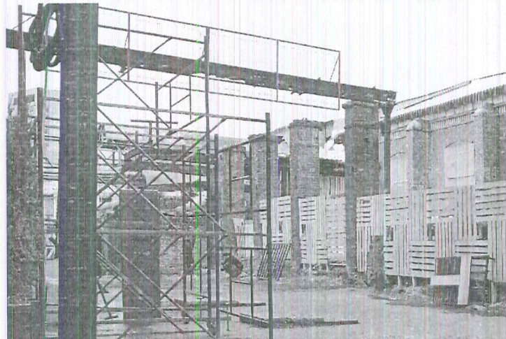
Кирпичные столбы, на которых был закреплен аппарат холодильной машины (генератора льда), 1897 год. Фото 2019 г.
