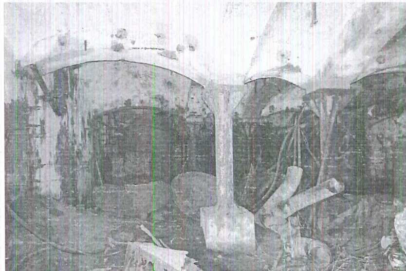
Подвал под двором при бродильне (основное помещение), 1884 год. Парусные своды на арках и металлических колоннах. Фото 2019 г.
