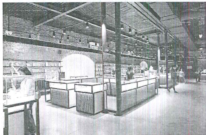
Ледник (1 этаж), 1875-1883 годы. Общий вид зала с плоским перекрытием на месте разобранных сводов Монье. Фото 2019 года.
