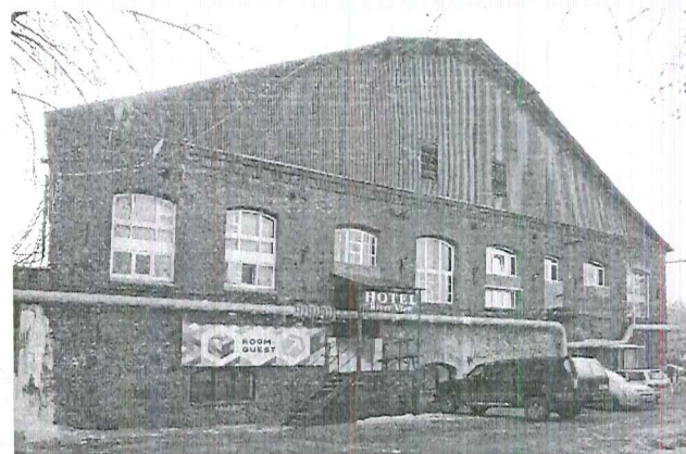
Бродильня и бутылочная мойка (северо-западный объем), 1906-1909 годы (северо-западный объем). Северный фасад. Фото 2019 года.
