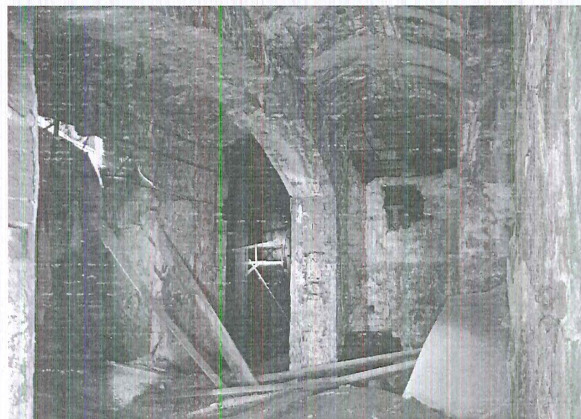
Подвал под двором при бродильне (северное помещение), 1884 год. Своды на арках. Фото 2019 г.
