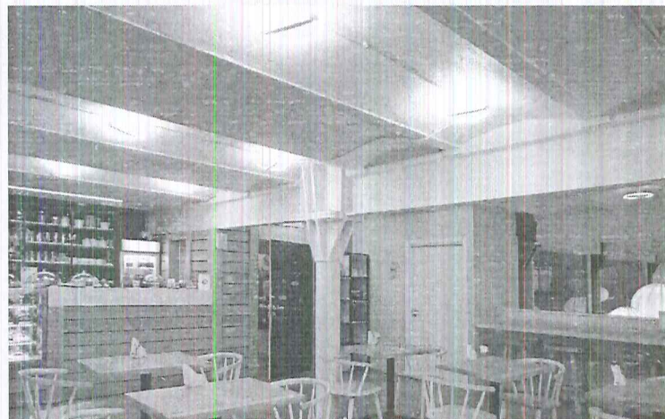
Новая бродильня (полуподвал), 1891 год. Своды Монье, железные колонны и балки. Фото 2019 г.
