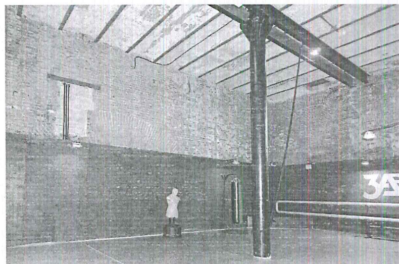
Новая солодовня (западная часть), 1906 г. Полуподвал: бывший цех солодорастильных барабанов. Своды Монье и чугунная колонна. Фото 2019 г.
