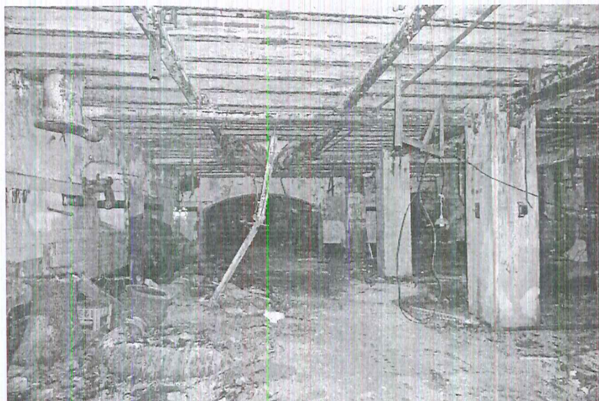
Корпус старой солодовни (западная часть), 1875-1883 гг. Подвал: цех-солодорастильня. Своды Монье и чугунные колонны, обложенные бетоном. Фото 2019 г.
