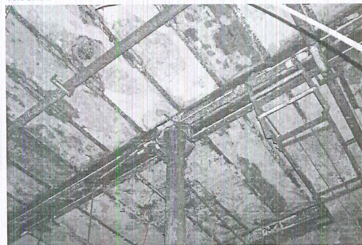
Новая солодовня, 1898 г. Подвал: цех для солодорастильных барабанов. Своды Молье и чугунная колонна. Фото 2019 г.
