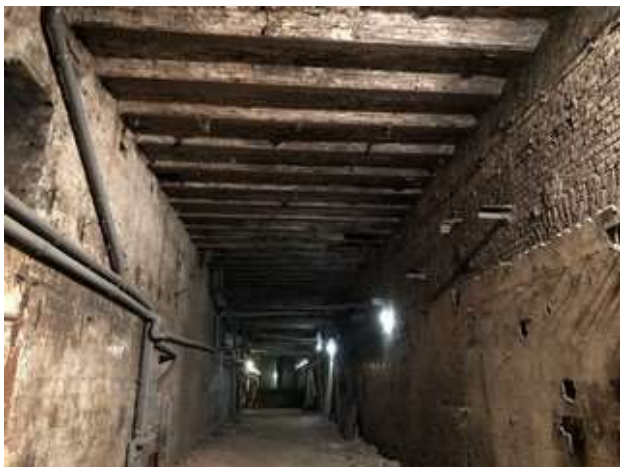
Коридор строения 1, со сводами Монье,
